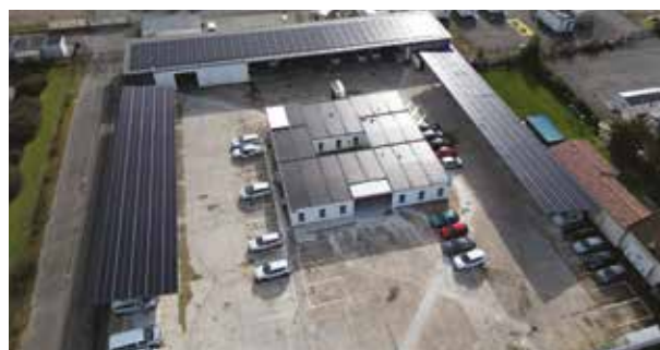
Ombrières de parking – trilogie Luçon (85) – 301kWc
