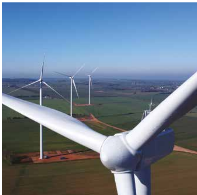
Parc éolien Les Monts – Moulin sur Orne (61)
