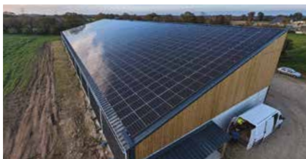
Toiture solaire sur bâtiment – Caden (56) 320kWc
